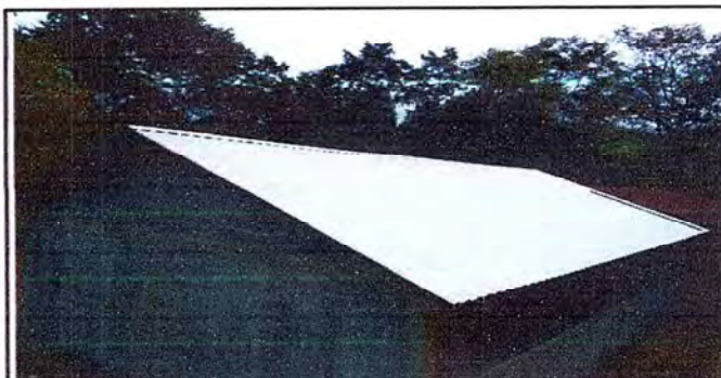
Foto 6: Vista del techo parte exterior.
