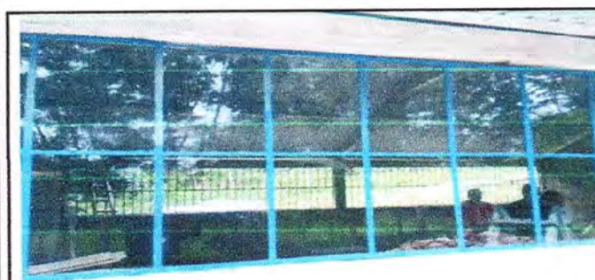
Foto 5: Vidrio colocado en las ventanas.
