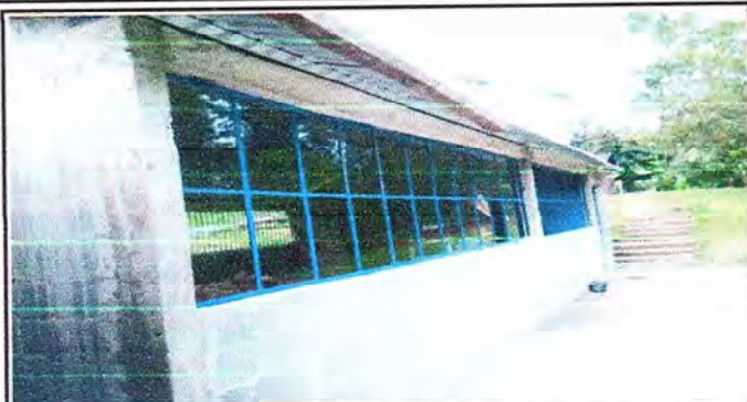
Foto1: Ventanas colocadas del aula de remozamiento.
